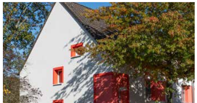
ImmoChance Deutschland 9 Renovation Plus: Bochum – nach Maßnahmen
